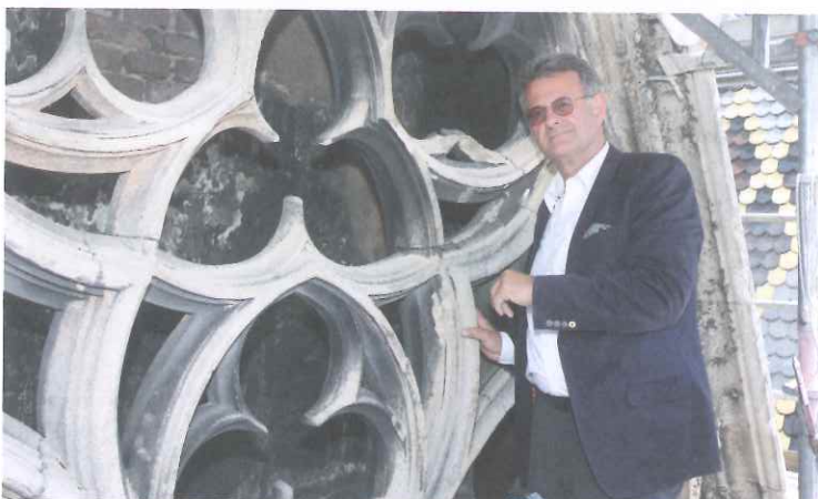
Dombaumeister Zehetner am Friedrichsgiebel. Hinter dem Maßwerk ist die Ziegelmauer zu erkennen.
