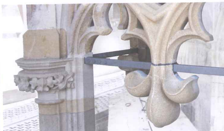
Starke Schäden an der Verbindung zwischen Eisen und Stein (links), dieselbe Stelle nach der Restaurierung (rechts)
