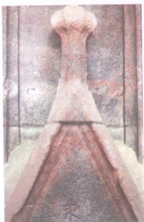
Rote Steinverfärbungen nach dem Brand 1945
