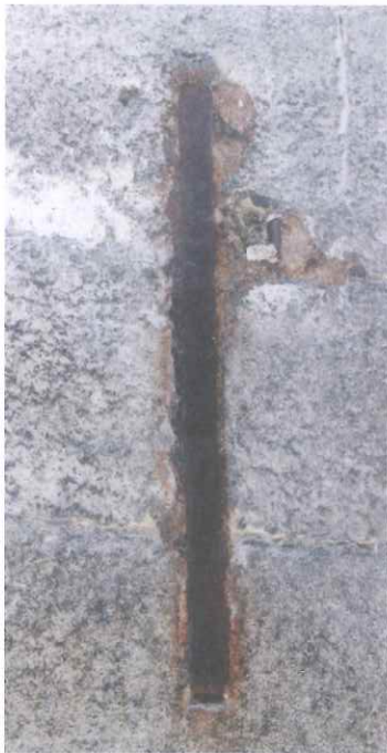
Mittelalterliche Steinklammer am Friedrichsgiebel
