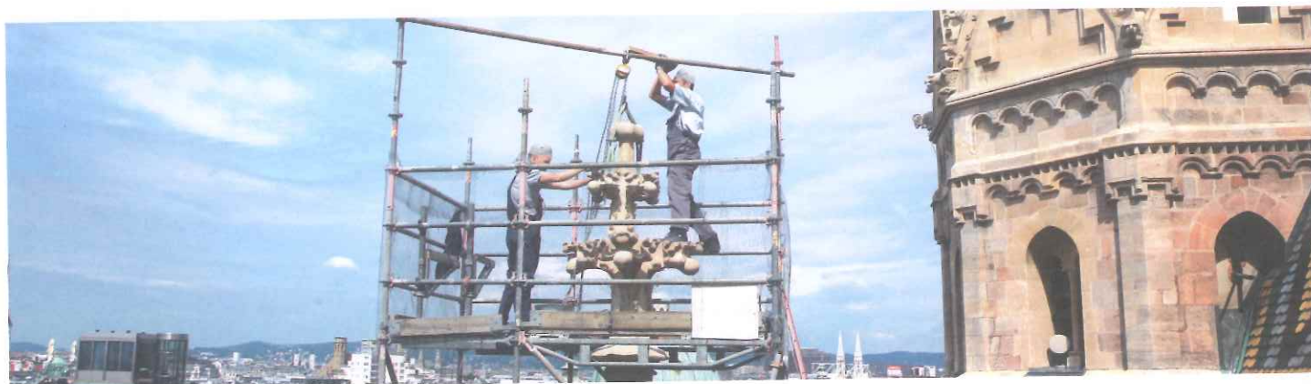
Der Abbau der Kreuzblume des Friedrichsgiebels
