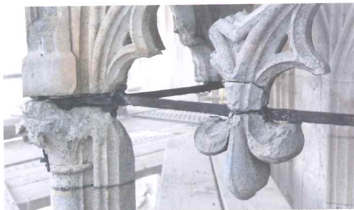
Starke Schäden an der Verbindung zwischen Eisen und Stein (links), dieselbe Stelle nach der Restaurierung (rechts)
