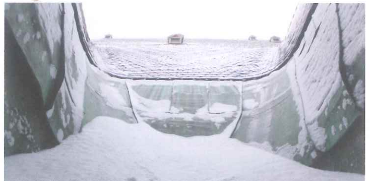
In der Dachrinne können sich große Schneemengen ansammeln
